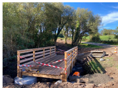
Pose de passerelle bois au-dessus du cours d'eau.
