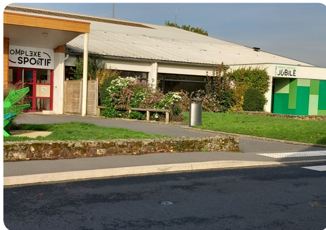
Signalétique des salles
