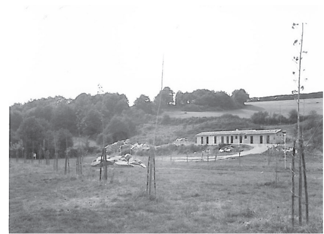
les premiers sanitaires
