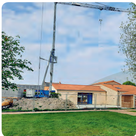
Extension du périscolaire
