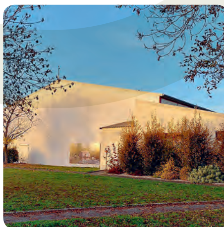
Salle omnisports Nettoyage de la façade
