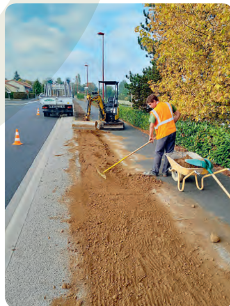
Travaux entrée du bourg côté Saint-Laurent
