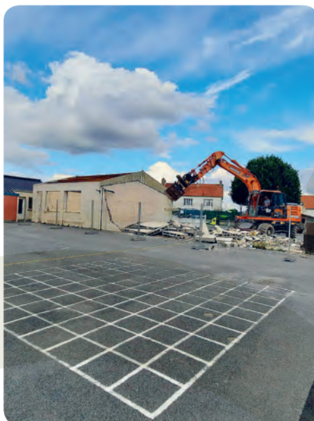
Démolition de l'école
